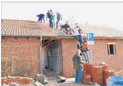
Mit der Achterkette hat der TuS rasch das Dach dicht.
