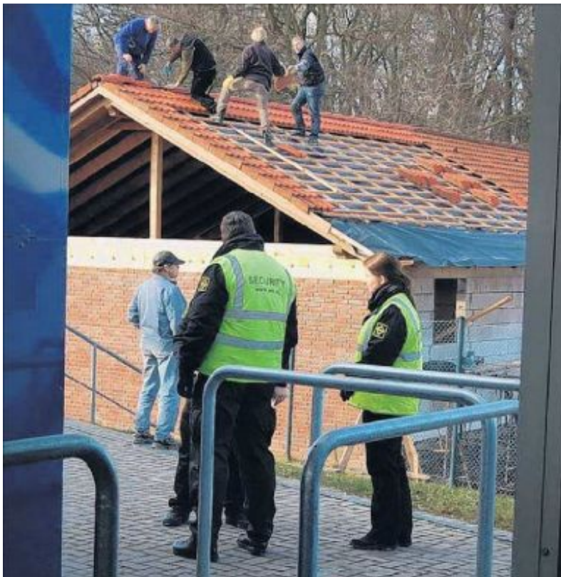
Die Dacharbeiten aus Sicht der Besucher des SFL-Heimspiels gegen Borussia Mönchengladbach in der PGW-Arena.
